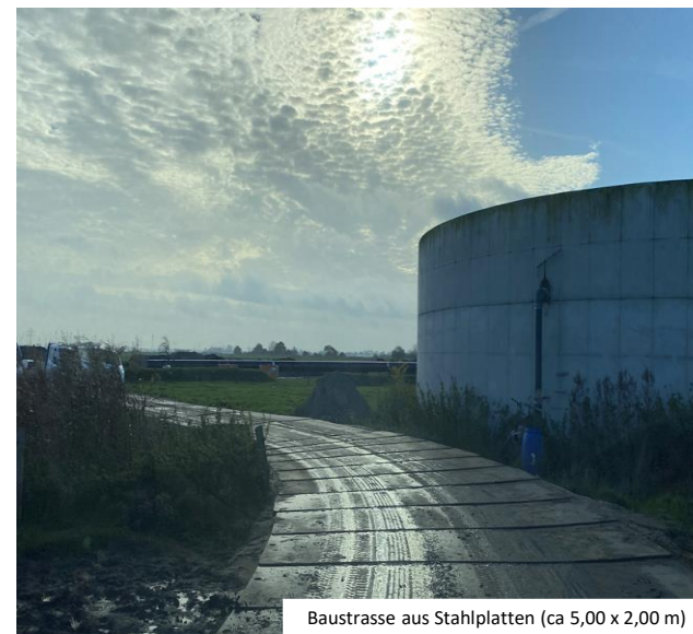
Baustrasse aus Stahlplatten (ca 5,00 x 2,00 m)
