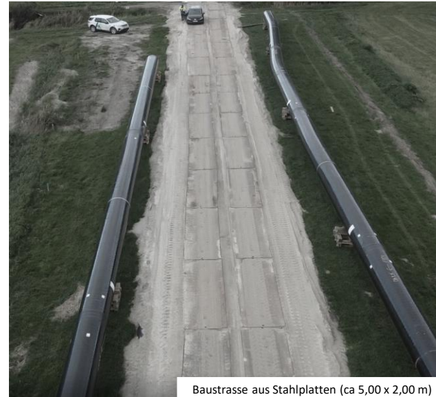
Baustrasse aus Stahlplatten (ca 5,00 x 2,00 m)
